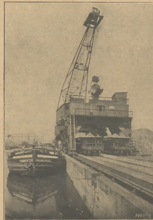
Abb. 4: Erzbrecher am Hafen Hardenberg mit Absiebovorrichtung
