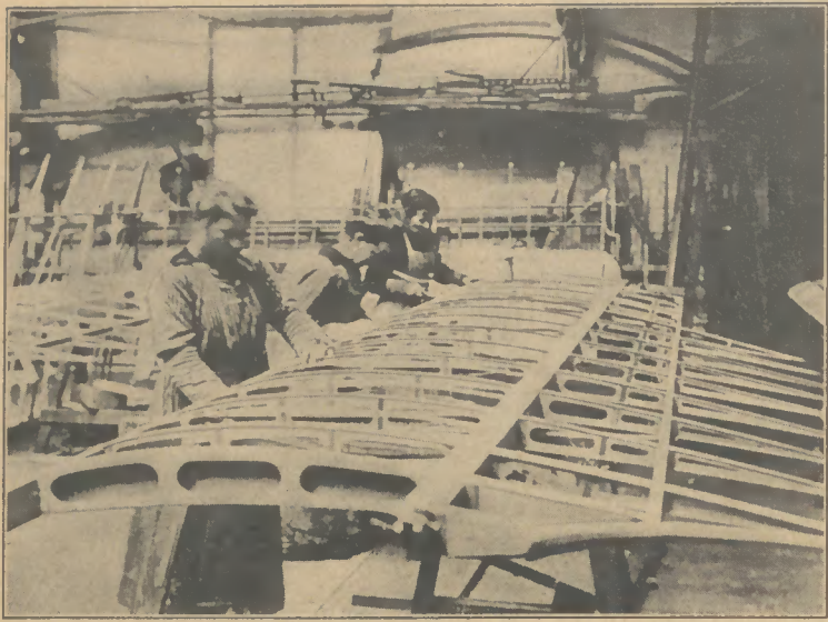
Tragflächen eines Sportflugzeuges im Bau
