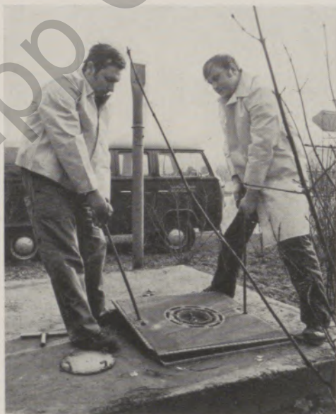
Kontrolle am Schieberschacht Haselbusch.
