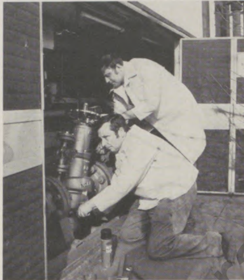
Montagearbeiten an den Armaturen der Anschlußstelle in Duisburg-Huckingen, wo sich auch eine Meß- und Regelstation befindet.
