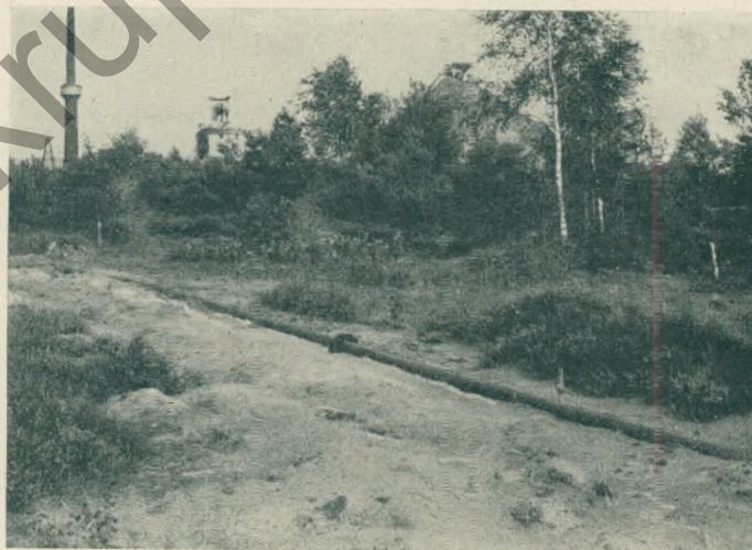
Zwischen Sand und Heidekraut eingebeitet verläuft die Schlagader der Industrie, die Erdölleitung.
