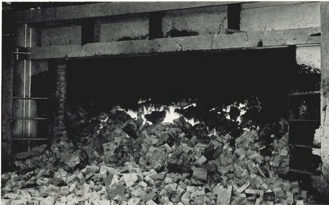
Nach der Sprengung: Die Vorderfront der Ausmauerung ist weggesprengt. Die zertrümmerte, noch glühende Schlacke liegt jetzt frei und kann mit dem Räumgerät weggeräumt werden
