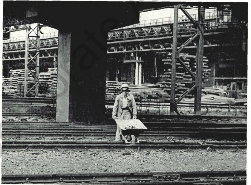
Um den Eisenbahnverkehr von der Doppelwaage an der Beize des Kaltwalzwerkes zur Zurichtung reibungslos und sicher abwickeln zu können, hat die Werksleitung eine neue Brücke über die gesamte Gleisanlage bauen lassen, die allen Anforderungen entspricht und auch dem Fußgänger einen kurzen und sicheren Überweg schafft. Leider gibt es noch unbelehrbare Mitarbeiter, die diese Brücke nicht benutzen, sondern die gefährvolle Gleisanlage direkt überqueren. Hierbei macht es manchen gar nichts aus — wie die beiden oberen Bilder zeigen — selbst mit ihrem Fahrrad oder einer Schubkarre diesen gefährvollen Weg zu wählen. Dabei werden diese Gleise fast pausenlos befahren; daneben lautlos anrollende Waggons der Rangierzüge bilden eine zusätzliche Gefahr.
