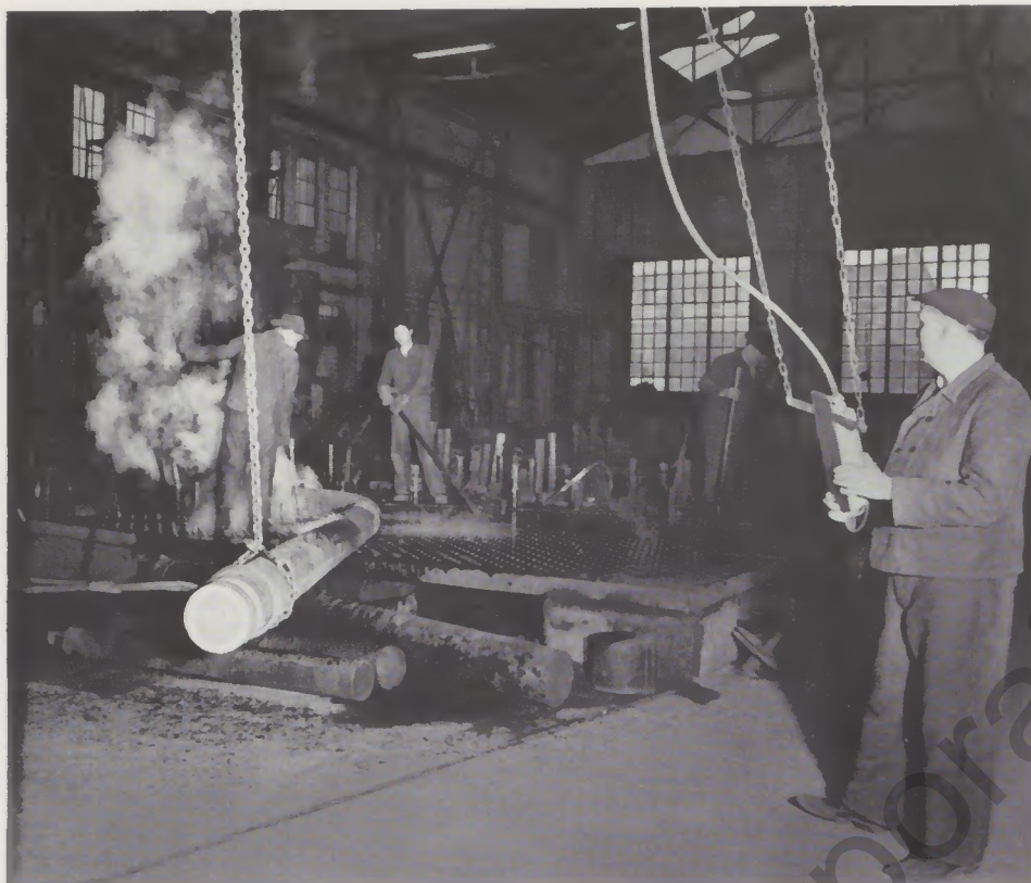
Hermann Müller GmbH., Rohrbiegen
