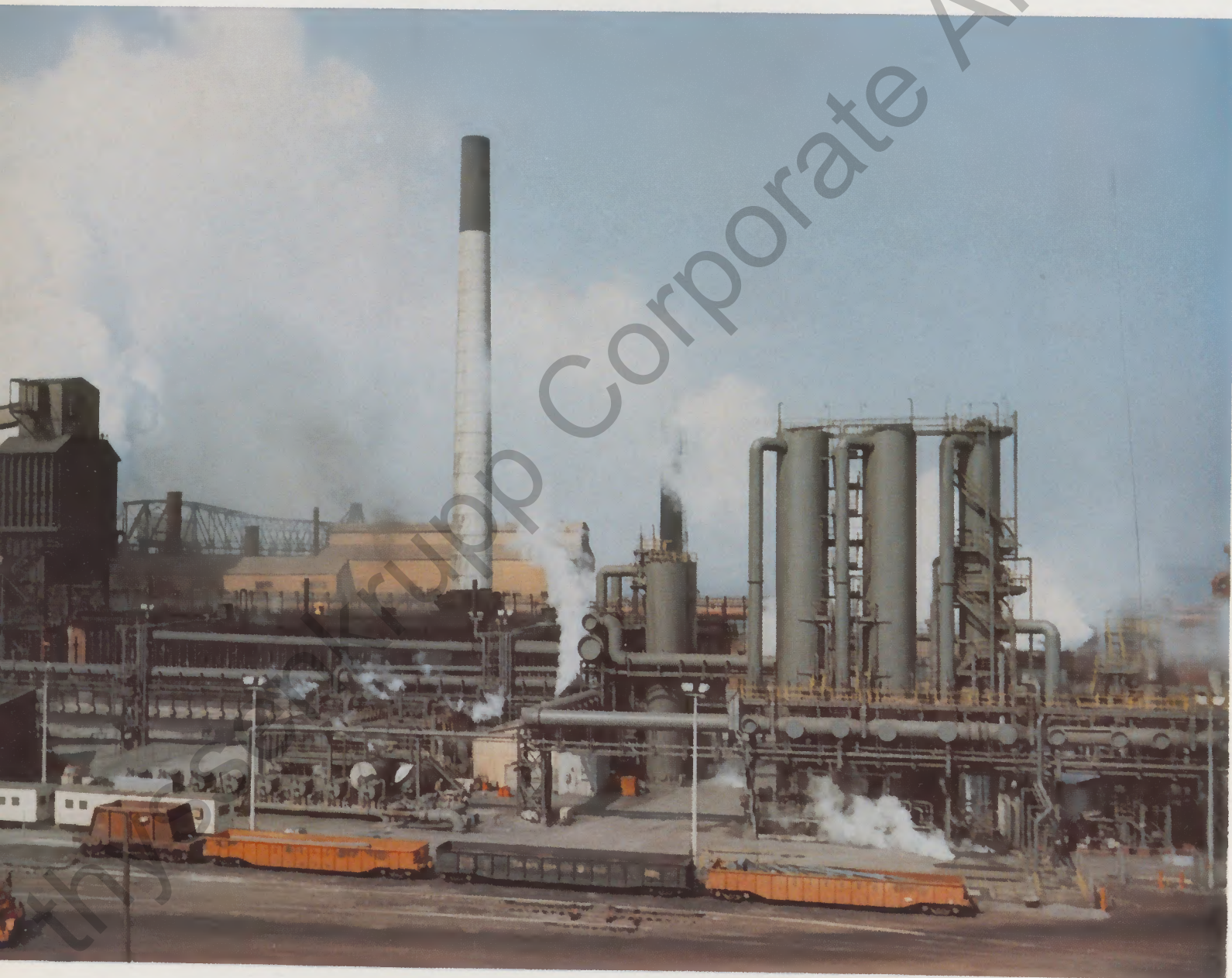
Otto-Anlage Hamilton/Ontario (Kanada)
