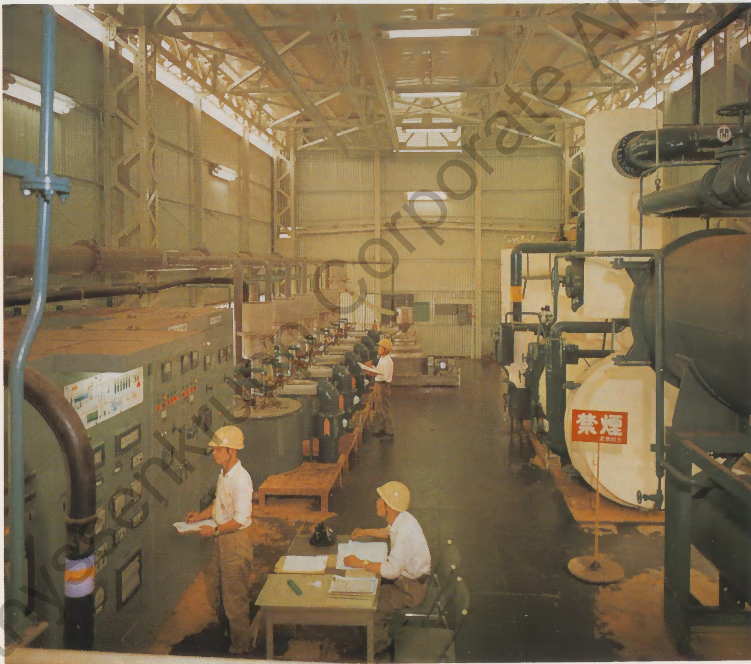
Intos-Kühlkristallisationsanlage Amagasaki, Japan
