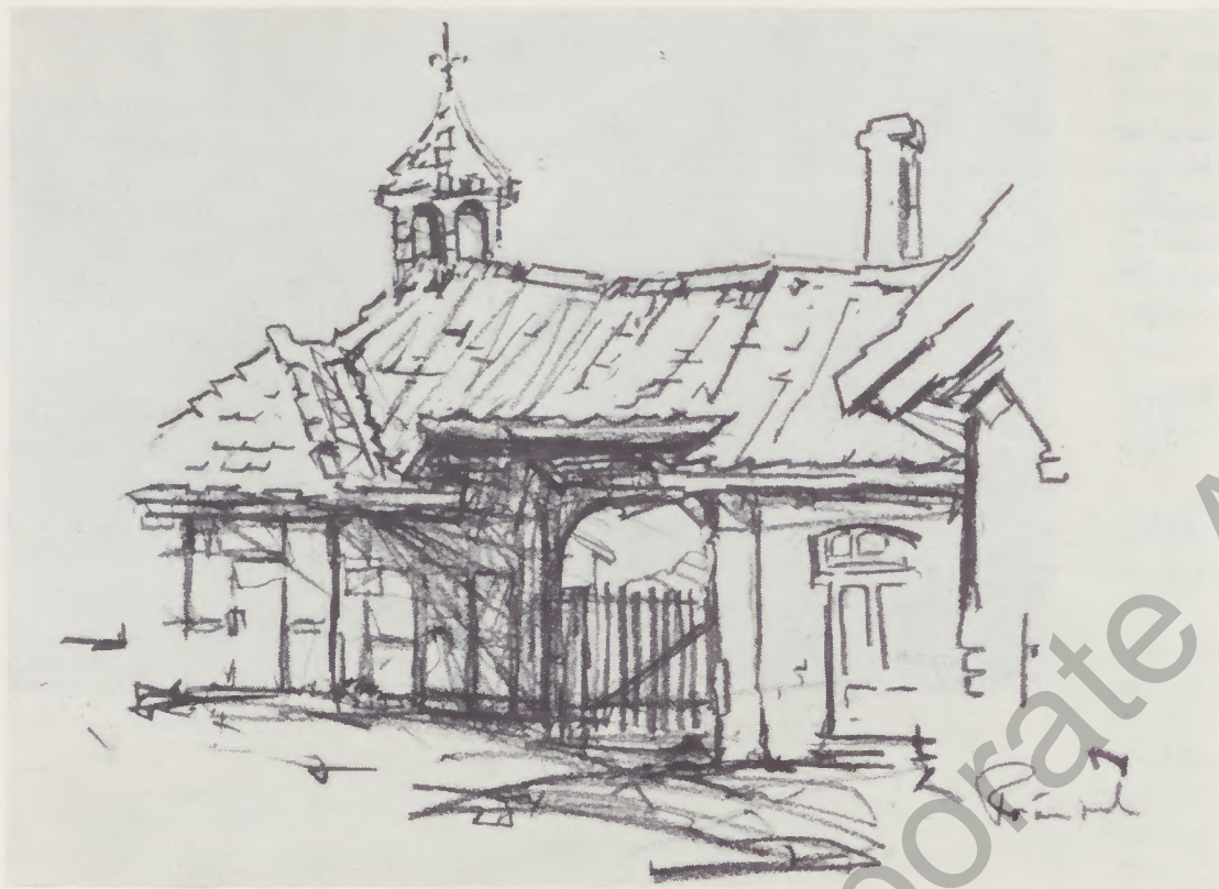
Das alte Torhaus der Steinfabrik Dahlhausen
