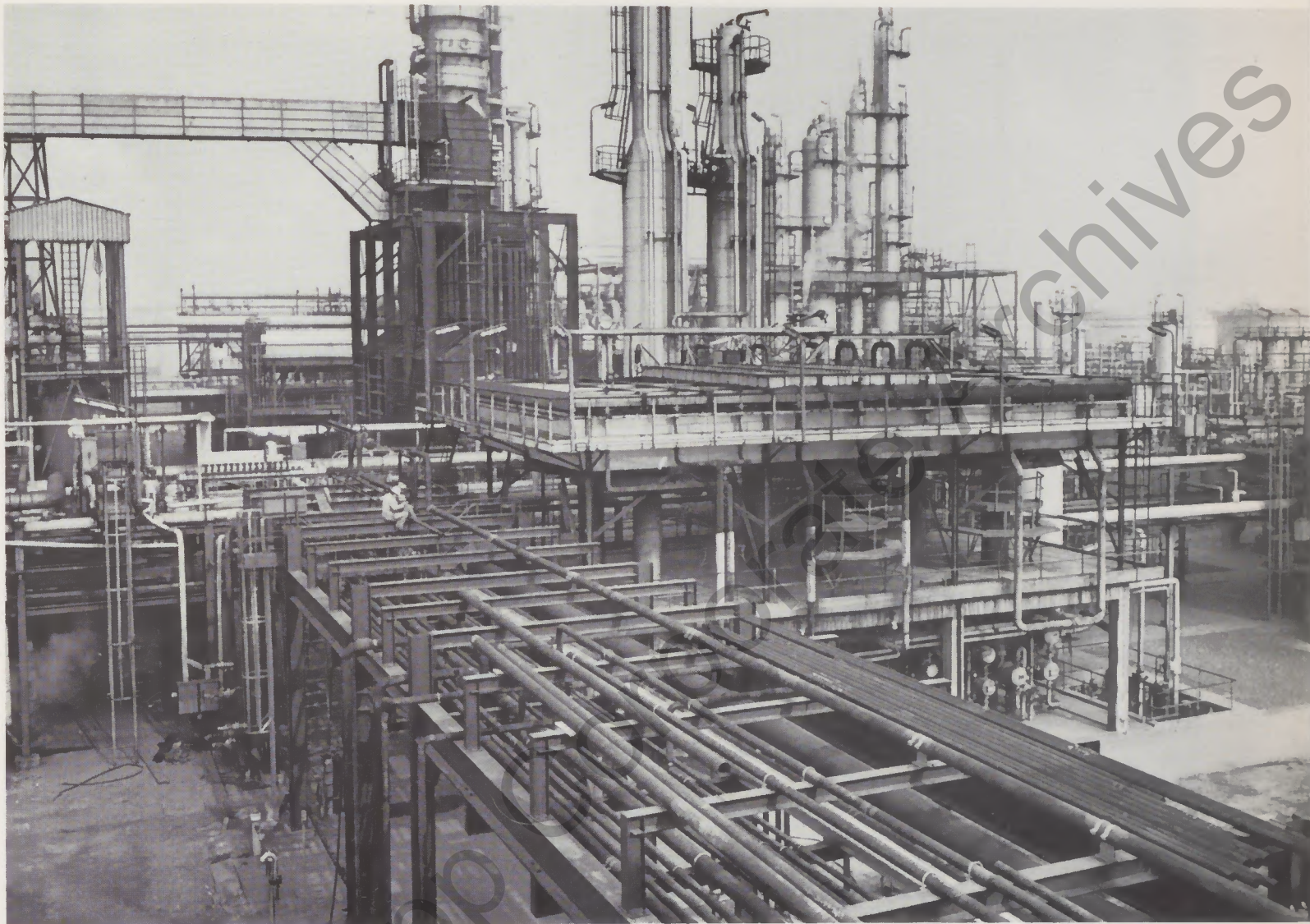
Rohrleitungsmontage in der Raffinerie Mannheim
