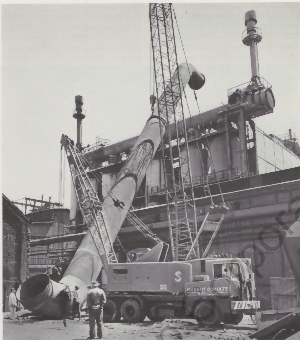
Anschluß einer Gichtgasleitung durch Hubert Schulte GmbH.
