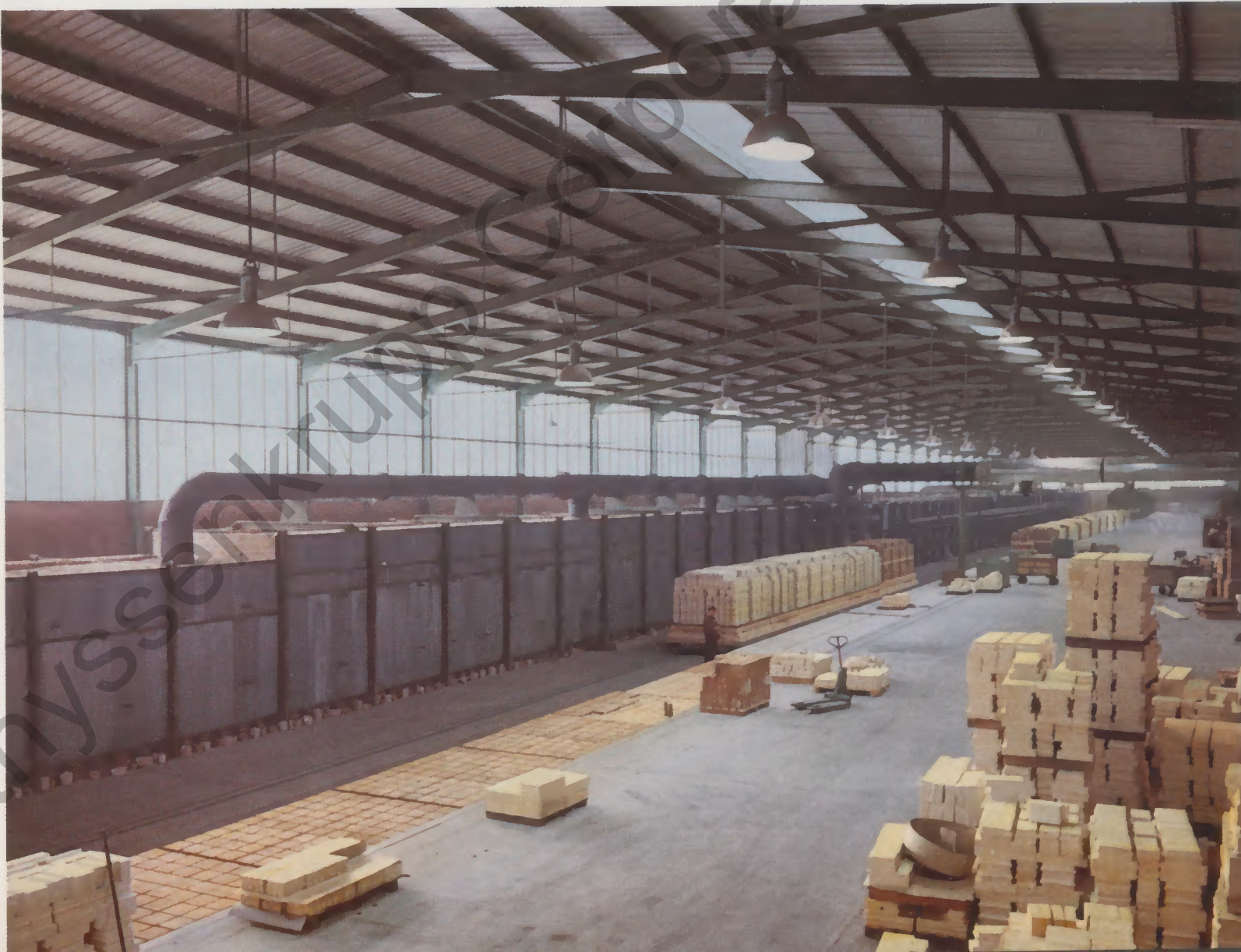
Neuer Tunnelofen zum Brennen von Silika-Steinen in Dahlhausen
