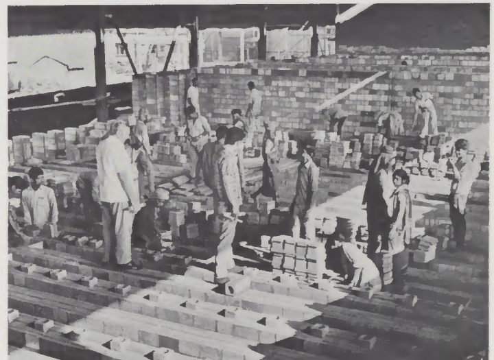
Bau einer Koksofenanlage in Indien
