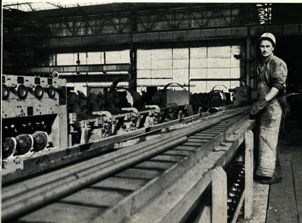
H. Bittermann (unten links) führt die Bördelprobe durch. Über Revisionsböcke, Richtmaschinen, Fräsbänke und Pressen (daneben) gelangen die Rohre zur Weiterverarbeitung
