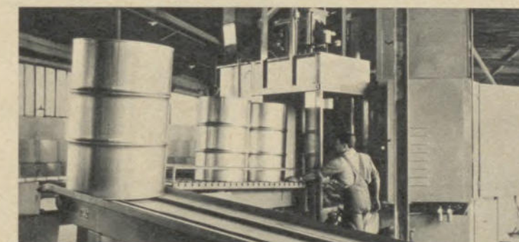
◀ Die geprüften Fässer laufen in die automatische Farbspritzanlage, wo sie ein- oder mehrfarbig spritzlackiert werden
