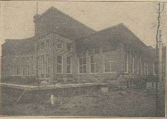
Das Rheinterassenrestaurant vor der Fertigstellung.
