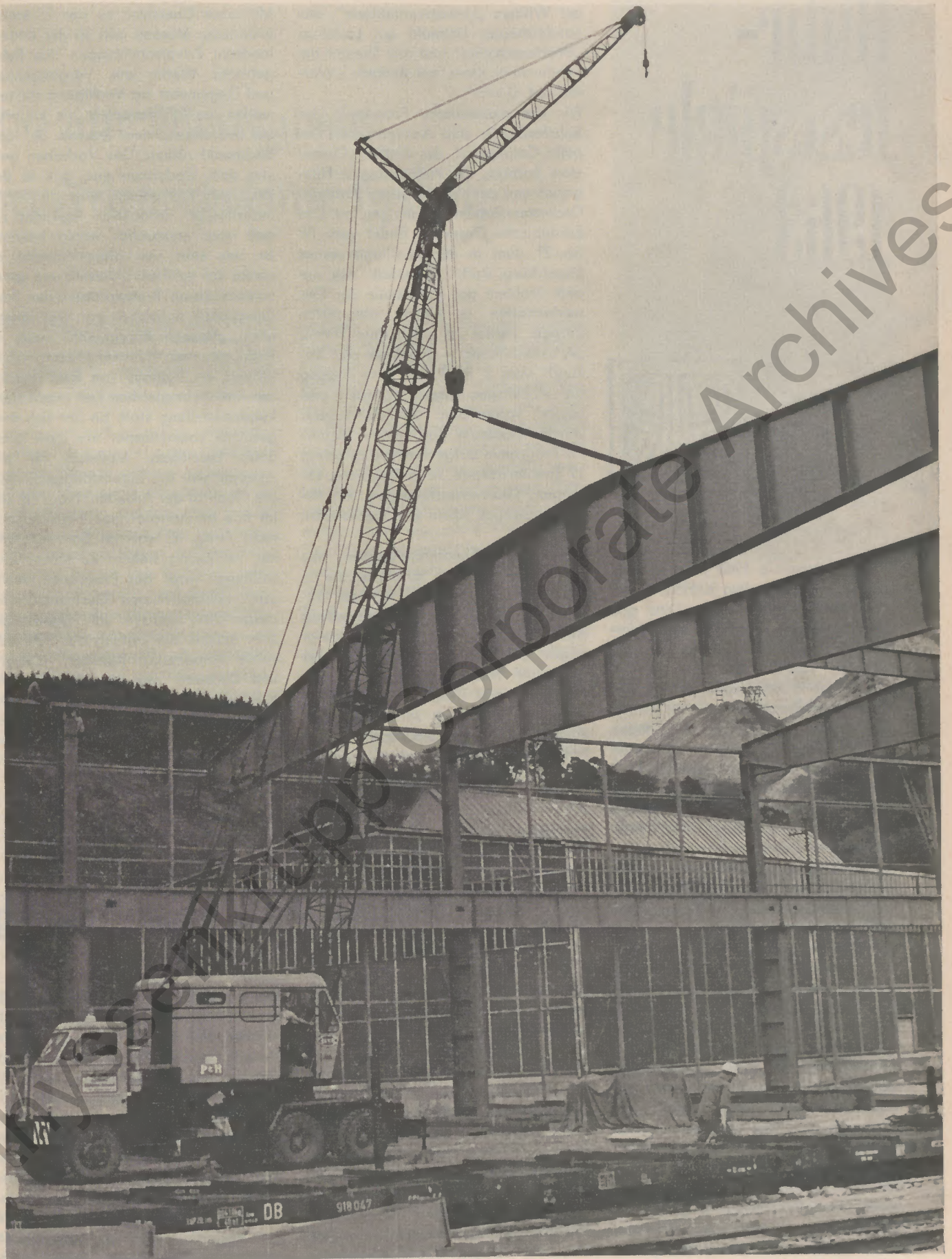
Verlängerung einer Lager- und Versandhalle. Montage der 17 t schweren Dachbinder.
