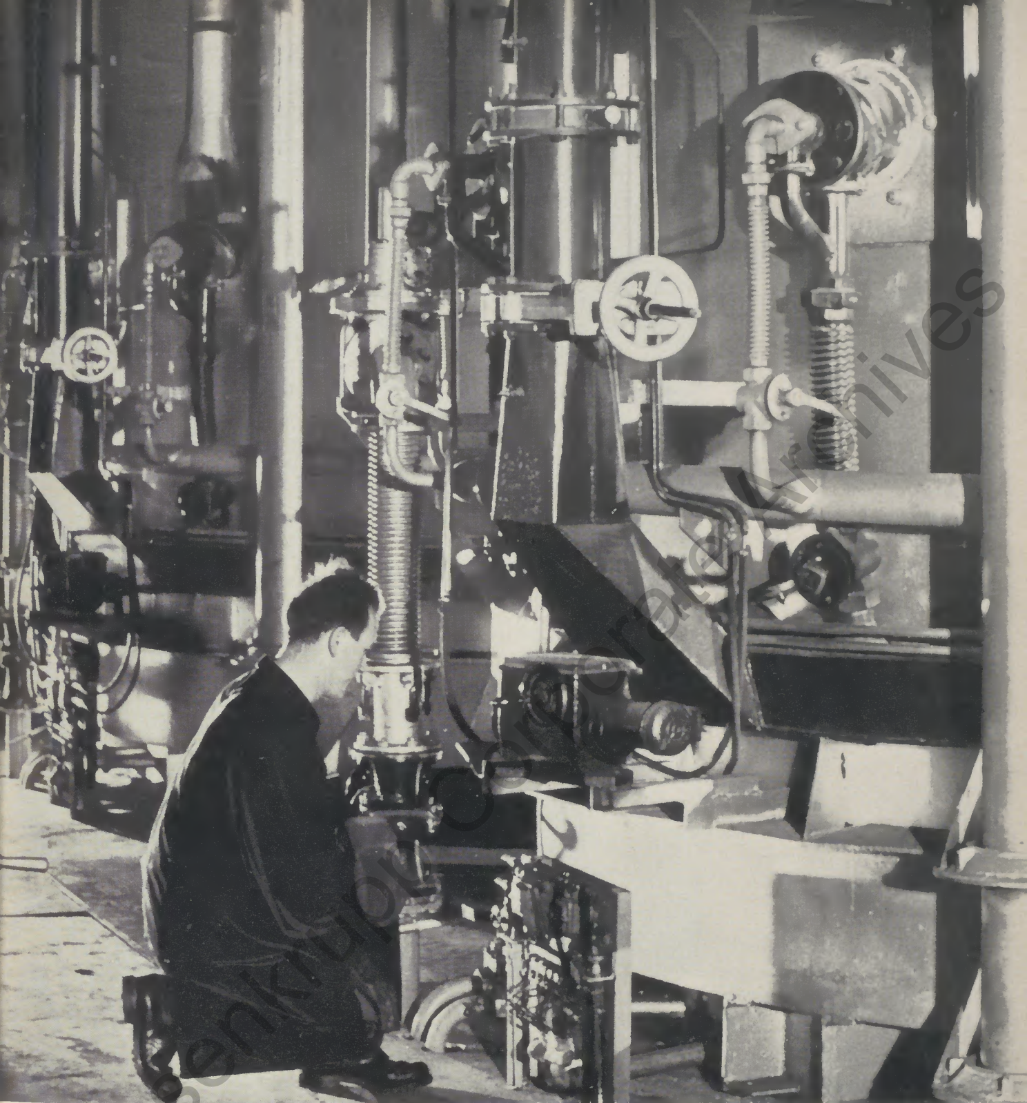
Anschluß der Thermoelemente am Ringglühofen in der Haubenglüherei (siehe Artikel Seite 63)
