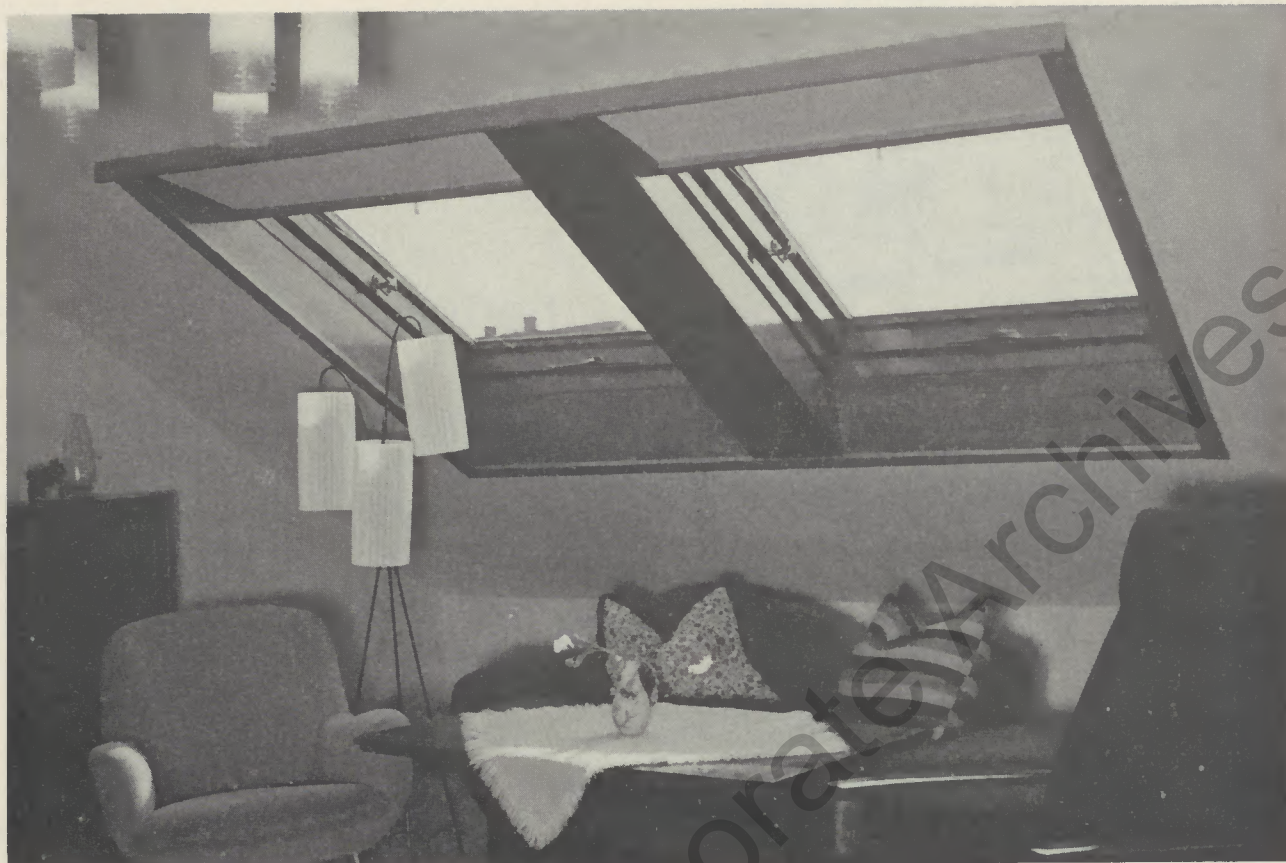
BLEFA-Wohnraum-Dachfenster mit Sperrholz verkleidet (Innenansicht)
