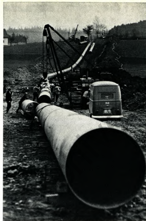
Auf der Trasse der Erdgasleitung Waidhaus — Nürnberg werden Leitungsteile vorgestreckt, d. h. die Rundschweißverbindungen werden mit WU-Schweißelektroden vom Typ Phoenix Cel 80 hergestellt.
