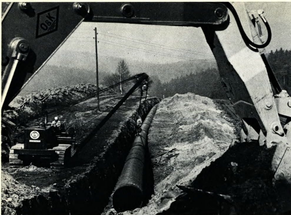
Seitenbaumtraktoren senken einen Rohrstrang der Erdgasleitung Waidhaus — Nürnberg in den Rohrgraben ab. Felsiges Gelände, wie hier im Oberpfälzer Wald, stellt besondere Anforderungen.
