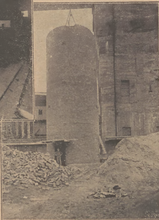
Der Bau des Kamines Januar 1927.
