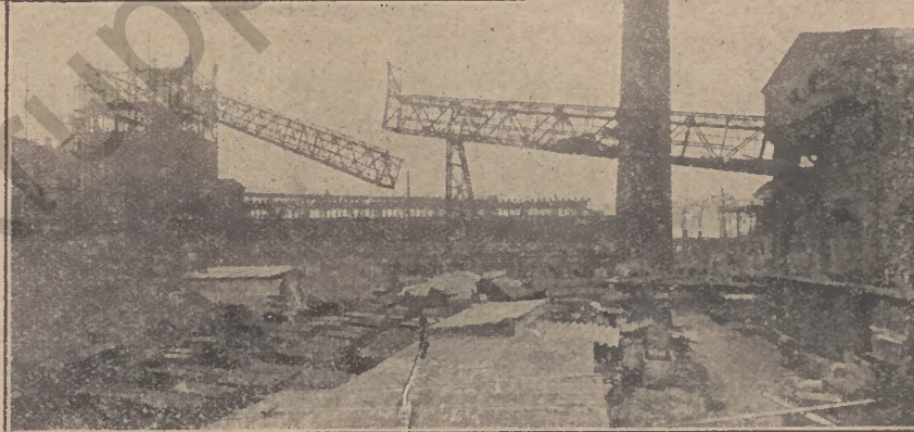
Hochziehen der zweiten Hälfte der Schrägbrücke vom Verteilungsturm zum Koks-enturm III.
