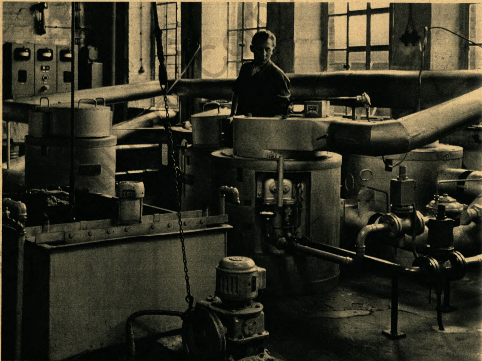
► In der automatischen Druckprüfanlage des neuen Hager Werkes der Hoesch Rohrwerke werden die fertigen Rohre auf ihre Druckfestigkeit überprüft
