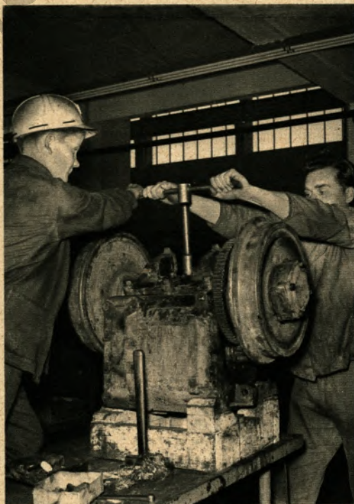
▲ Berglehrling Karl-Heinz Bande hilft dem Elektriker Willi Lobitz bei der Überholung des Motors einer Unter-Tage-Akku-Lokomotive
