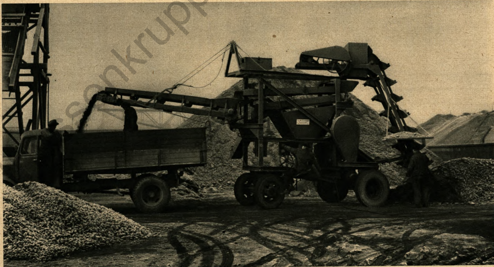
▼ Im Frankfurter Kohlenlager der Hoesch Reederei und Kohlenhandel dient ein fahrbarer Löffelbagger der Kohleverladung
