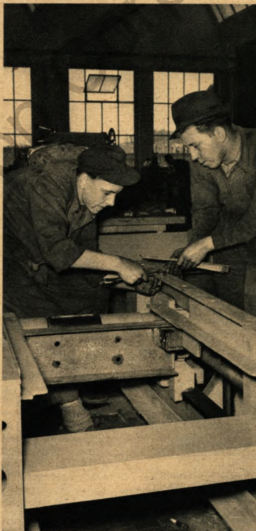
▲ Schlosser Hans Bemba (rechts) und Lehrling Fritz Joos reparieren die Umkehr eines Stahlgliederbandes
