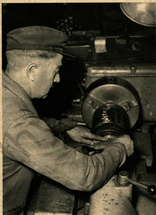
▲ Bernhard Schütte beim Abdrehen eines Ankers für eine Akku-Lokomotive – eine der vielfältigen Aufgaben, die in der Hauptwerkstatt täglich anfallen
