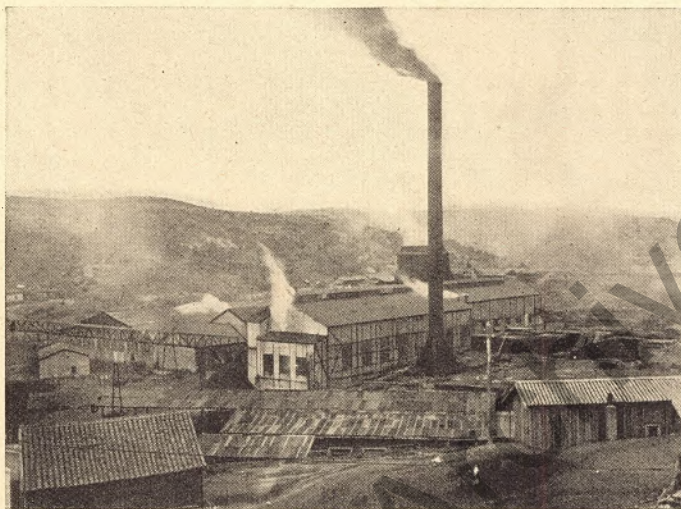
Abb. 6. Kohlenminen Curanilahue (Zentrale und Kesselhaus)
