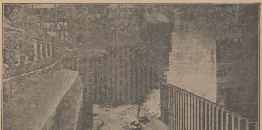
Vorstehend: Gründungsarbeiten für das Dock des argentinischen Kriegshafens. Puerto Militar bei Bahia Blanca. Links nebenstehend: Baugrube für die zweite Abfliegelschleuse des Rhein-Herne- Kanals in Duisburg. Bild II: Während der Wasserabsenkung.
