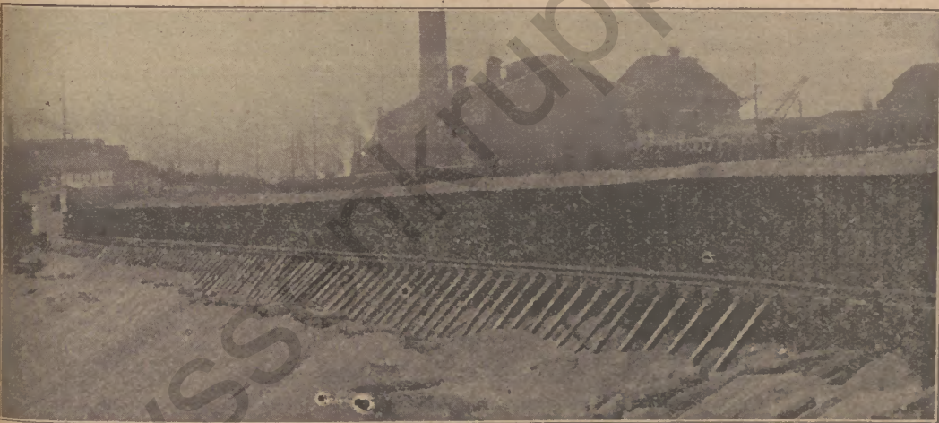
Baugrube für die zweite Abfliegelschleuse des Rhein-Herne-Kanals in Duisburg. Bild III: Nach der Wasserabsenkung.
