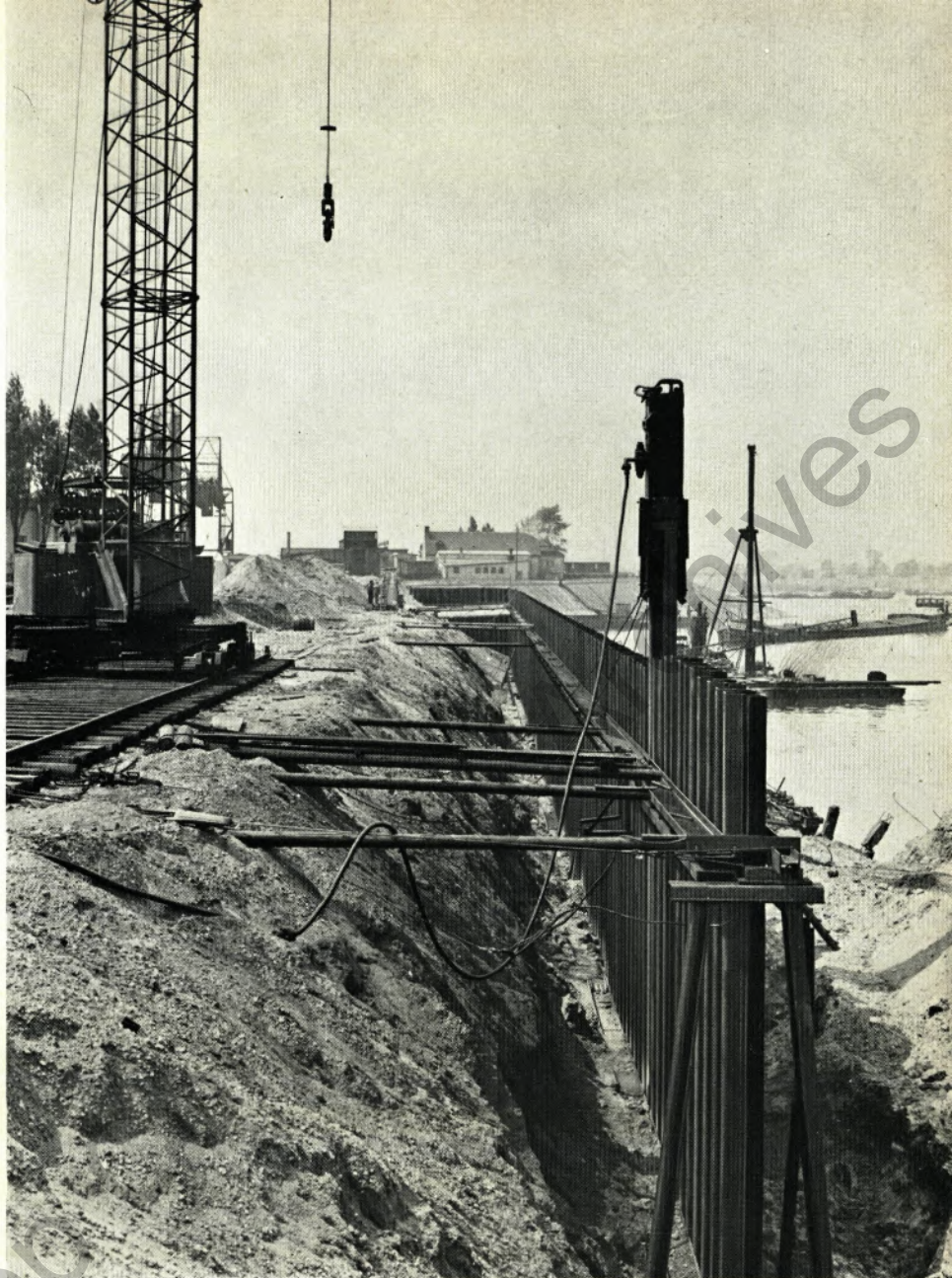
Ein Schlaghammer im Vordergrund auf der neuen Spundwand rammt die einzelnen Bohlen in den Boden.
