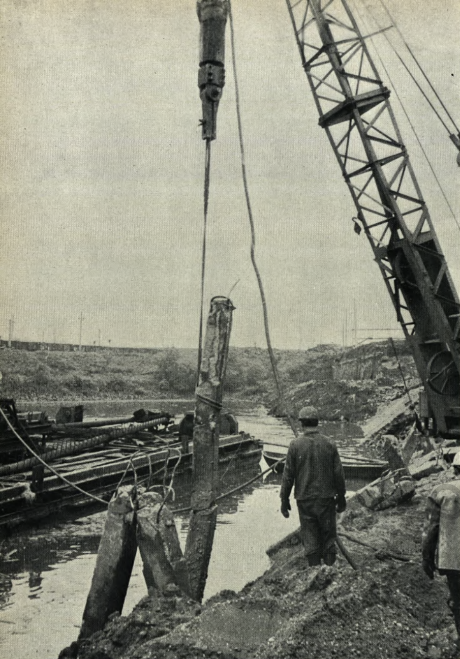
Die Stahlbetonpfähle der alten Kaimauer werden mit dem Bagger aus dem Erd- reich gezogen.
