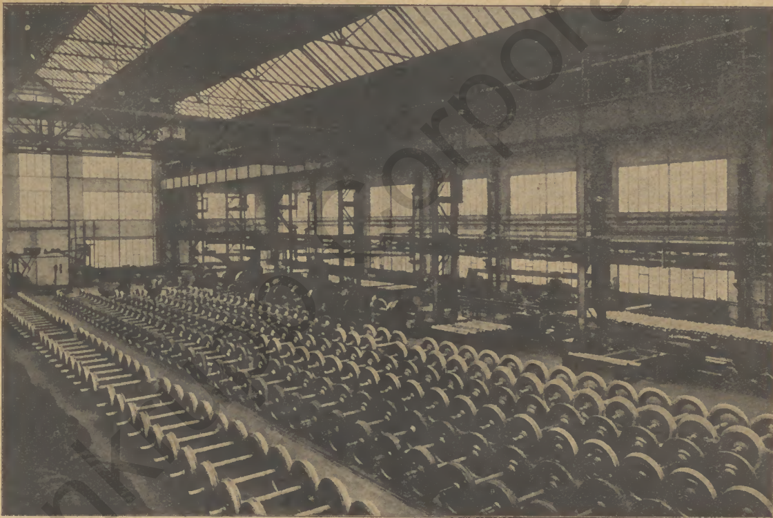
Abnahmehalle unserer Wagen-Radschwerkstatt.
