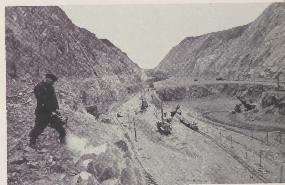
Der Tagebau im Kirunavaara hat eine Länge von 3,3 km und eine Breite bis zu 400 m. Der Abbau erfolgt im Terrassenbau. Die Sprenglöcher werden vertikal mit Hilfe von Blockbohrmaschinen gebohrt.
