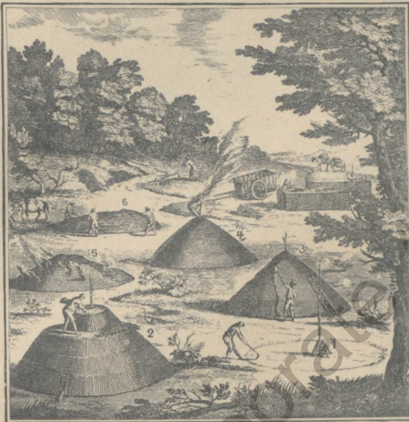
Abb. 1: Bau und Betrieb eines Meilers
