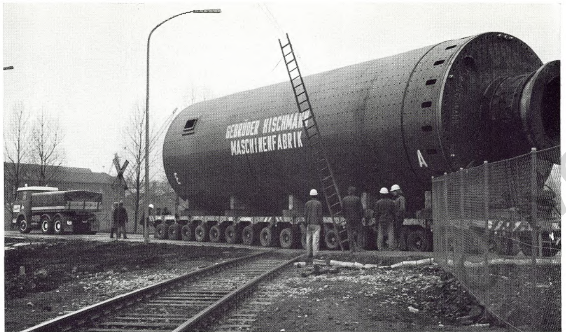
Das Mühlenrohr mußte mit dem Tieflader vom Hafenbecken ein Stück über Land zur Baustelle transportiert werden
