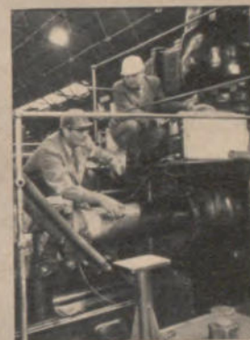
14 Prüflingenieur Friedrich Börnicke (links) und Meister Walter Abeck prüfen und begutachten die Kolbenstange des Kompressors 11 der Gaszentrale im Werk Westfalenhütte
