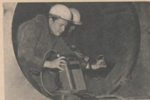
10 Mit Ultraschall kontrollieren Alfred Rösen (rechts) und Willi Middelman die Schweißnähte eines schweren Pressenständers
