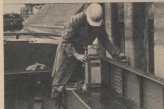
14 Prüflingenieur Friedrich Börnicke (links) und Meister Walter Abeck prüfen und begutachten die Kolbenstange des Kompressors 11 der Gaszentrale im Werk Westfalenhütte
