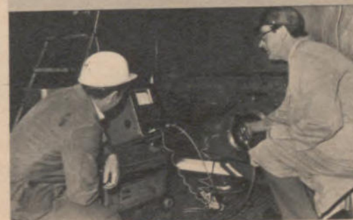
15 Auf Anbrüche untersuchen diese E-Lok-Achse Prüflingenieur Friedrich Börnicke und Karl-Heinz Penczek (links) mit Ultraschall
