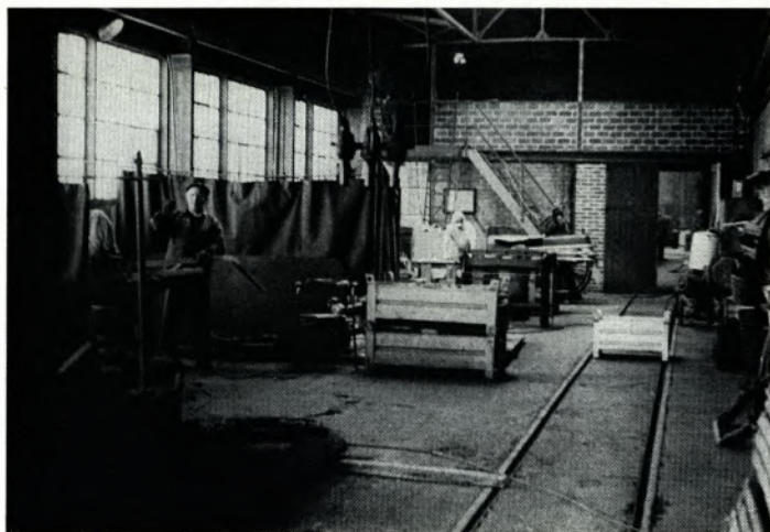
Die Schweißerei noch im Anbau der Halle 1. Sie erhält später ihren endgültigen Platz mit in Halle 9.
