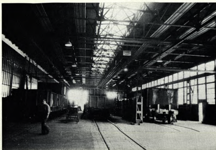
Halle 15 – Innenansicht. Vorn rechts der provisorische Bremsprüfstand, dahinter liegt der Hebestand, während auf den beiden benachbarten Gleisen der Neu-Anstrich erfolgt.
