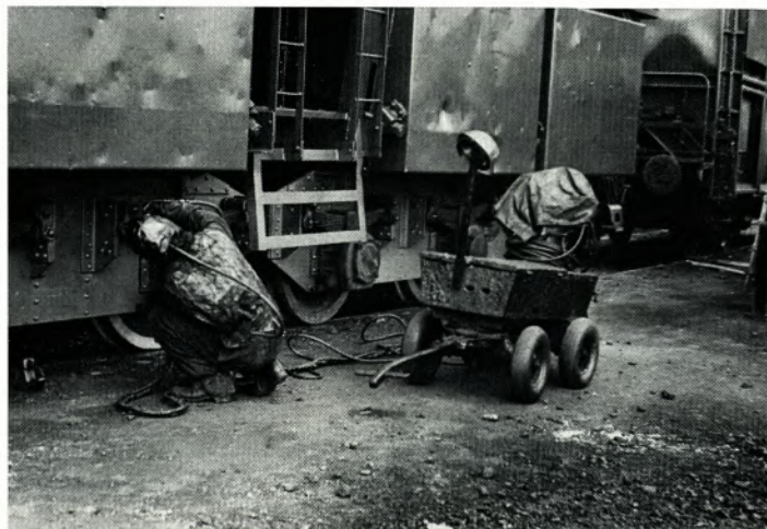
Bisheriger Wagenanstrich mit Hilfe von Druckluft-Spritzpistolen im Freien.
