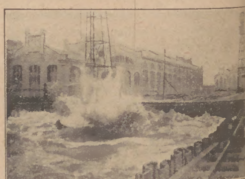
Vortrieb der Vorhellinge in die See, beim der Hellinganlage im Hafen von Valencia.
