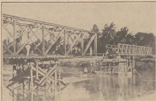
Brückenbauten der Dortmunder Union auf Java (Niederl. Indien. — Aufnahmen während der Montage.
