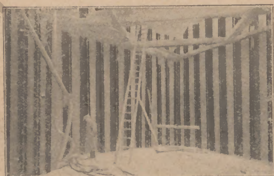
Brücke bei Rödöfönd-Schweden. Pfeilergründung.
