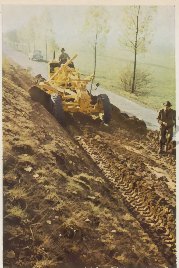
Abb. 5 Henschel-RMW-Grader beim Schneiden einer Böschung
