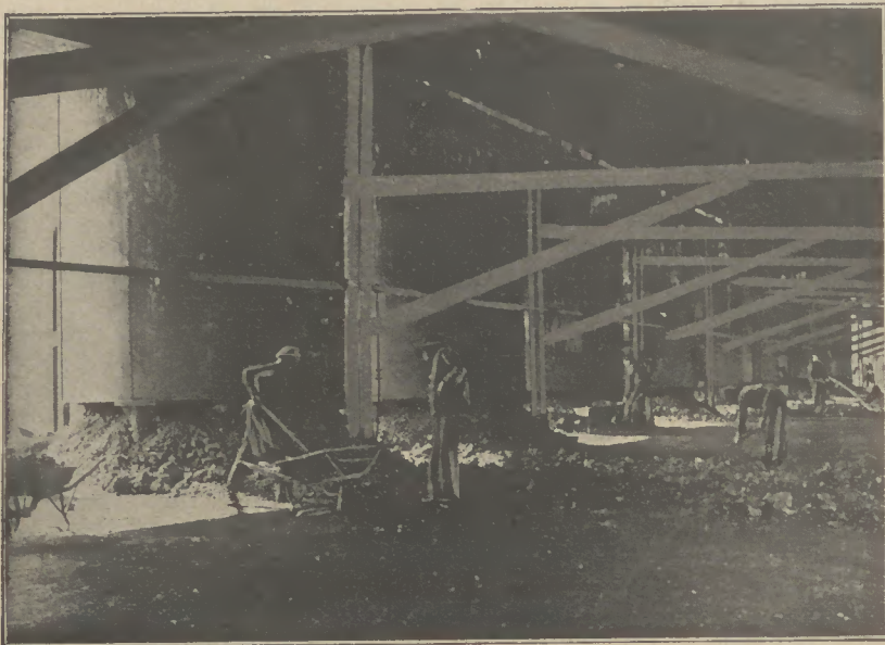
Teilansicht der Röstanlage einer Eisenerz-Zeche.
