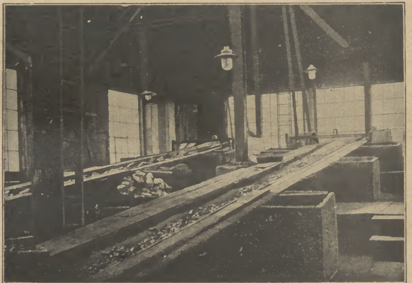
Leesebandanlage in der Rohspat-Aufbereitung einer Eisenerz-Zeche.
