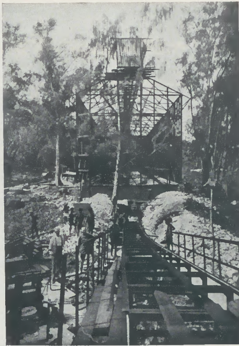
Phosphat-Gewinnung auf Angaur. Trockenlager im Bau. Im Vordergrund die Förderstrecke, die zur Verladestation führt.
