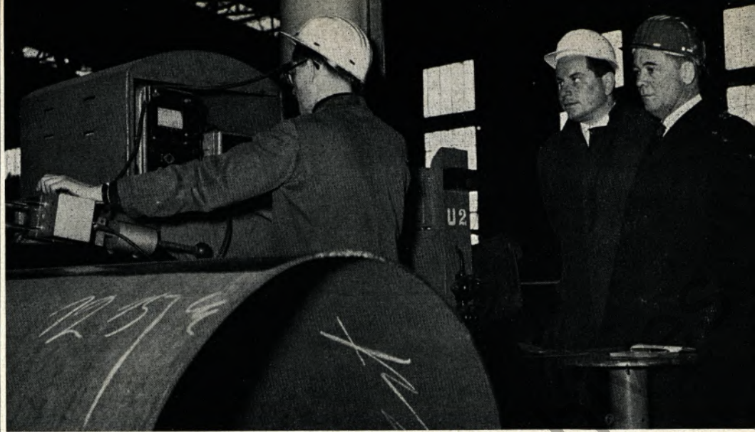
Prok. Thielke erläutert auf dem rechten Bild Mr. Malcolm, Chief Coordinator der Esso International, London, die Prüfung der Schweißnähte von Großrohren mit Hilfe eines Ultraschallprüfgerätes
