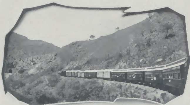
Auffahrt zum Tunnel bei San Roque Ganz links der Tunnelmund
