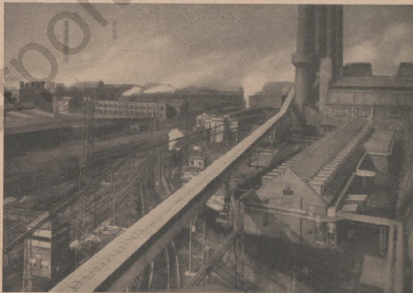
Bandförderanlage für eine Stundenleistung von 500 Tonnen
