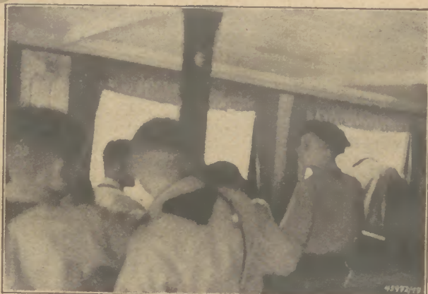
Bei der Hafenrundfahrt in Bremen
