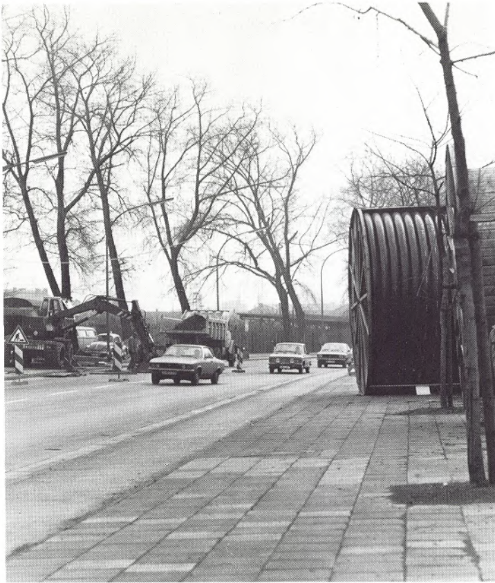
Bild oben: Zwischen Hochofen und Schwelgernbad liegt eine Straße, die Neue Schwelgernstraße. Sie wird von der Warmwasserleitung (im Bild rechts noch aufgewickelt auf der großen Trommel) unterquert. Die Baggerarbeiten (Bild) sind inzwischen abgeschlossen.
