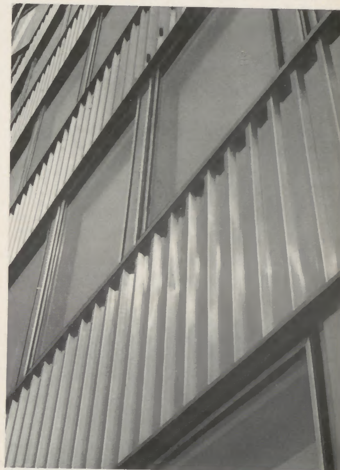
oben: Teilansicht der REMANIT-Fassade eines Verwaltungsgebäudes in Düsseldorf
