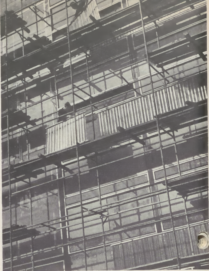
REMANIT-Brüstungstafeln werden am Institut für Werkstoffkunde in Aachen angebracht
