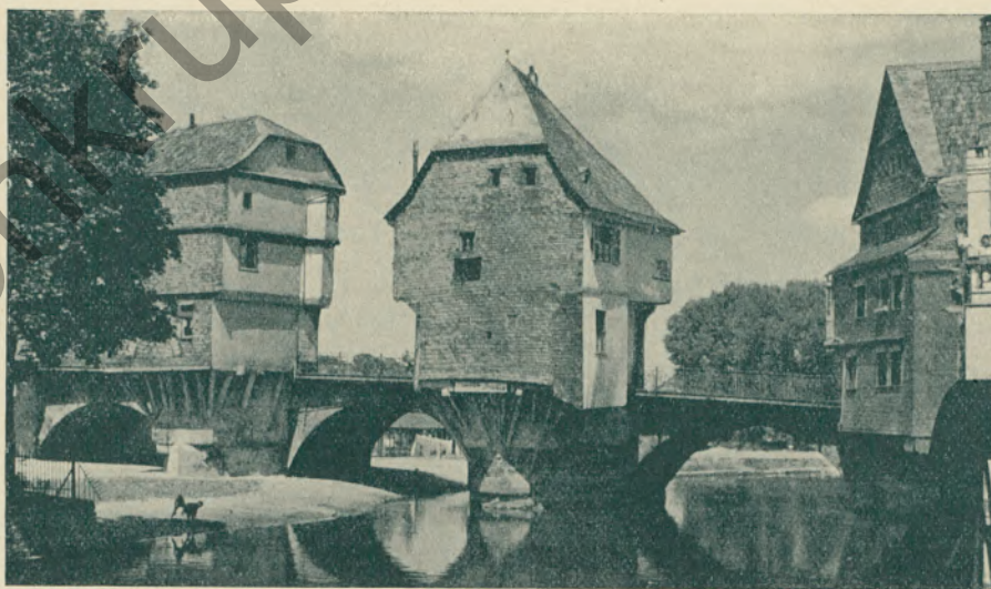
Nahebrücke in Kreuznach mit drei Öffnungen von ungefähr 16 m Weite; über den verlängerten Pfeilern stehen ausragende Häuser.
