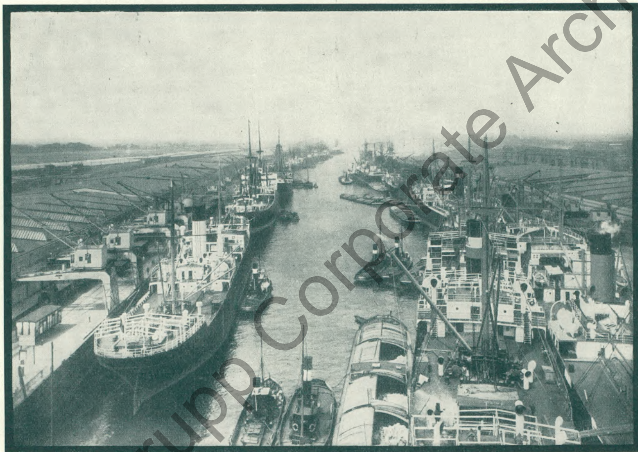
Abb. 10. Neue Kaianlagen in Bremen mit einstöckigen Raishuppen und vierstöckigen Lagerhäusern.
