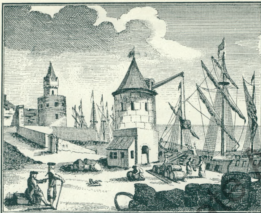
Abb. 1. Holländischer Seehafen zu Anfang des 18. Jahrhunderts. Im Vordergrund ein Drehkran mit Haspelantrieb.
