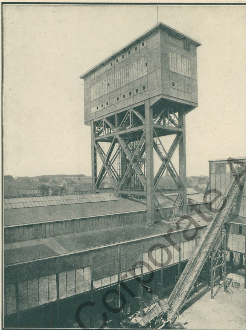
Die Turmförderanlage des Schachtes „Emil Rirdorf“ Zeche „Minister Stein“, Dortmund, der „Vereinigte Stahlwerke Aktiengesellschaft“.
