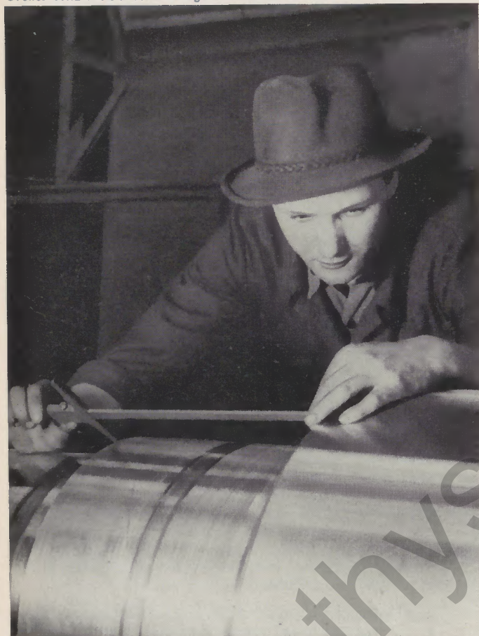
Der Mensch in der Arbeit: Drehen Fritz Deus beim Fertigdrehen einer 4 t schweren Walze
