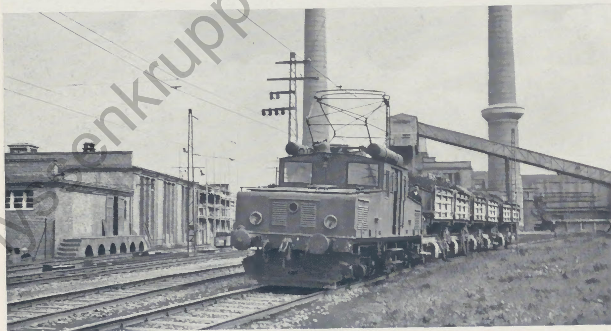
Elektrische Henschel-Lokomotive für Oberleitungs- und Speicherbetrieb im Großkraftwerk Borken, Bez. Kassel
