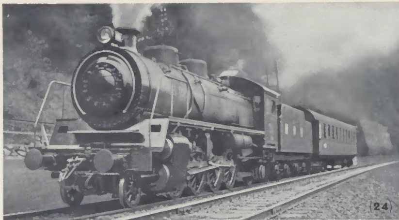
1 D 1 - Heißdampf - Zwillings - Güterzug-Lokomotive für die Chekiang-Kiangsi-Bahn
