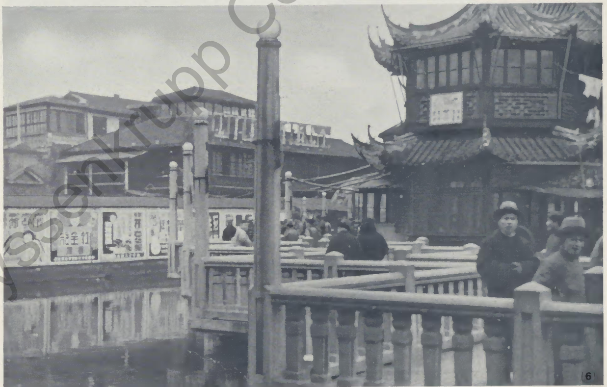
Fußgängerbrücke in Nantao (südliche Chinesenstadt Shanghais)
