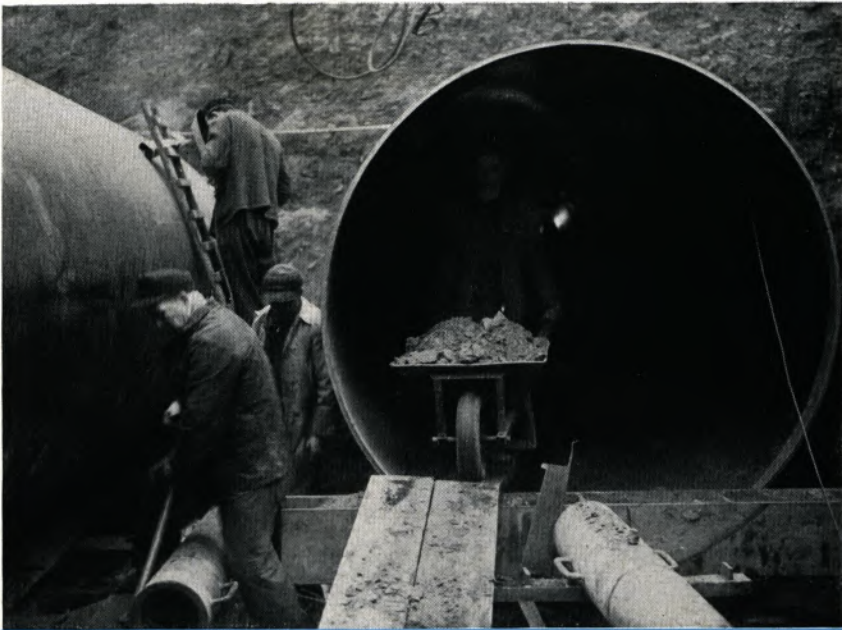
2 m Durchmesser haben diese riesigen Rohre, die VRB-Arbeiter als Abwasserleitung mit vielen Anschlüssen am Pumpwerk der alten Emscher in Duisburg-Stockum verlegen
