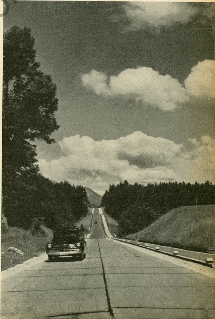
Jugoslawien baut moderne Straßen (hier Slowenien)
