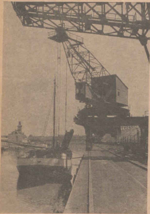
Einladen der Spundbohlen in Rähne
