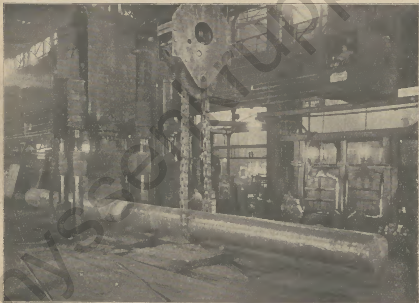
Abb. 5: Geschmiedete Pressensäule für die 15 000-Tonnen-Pressen
