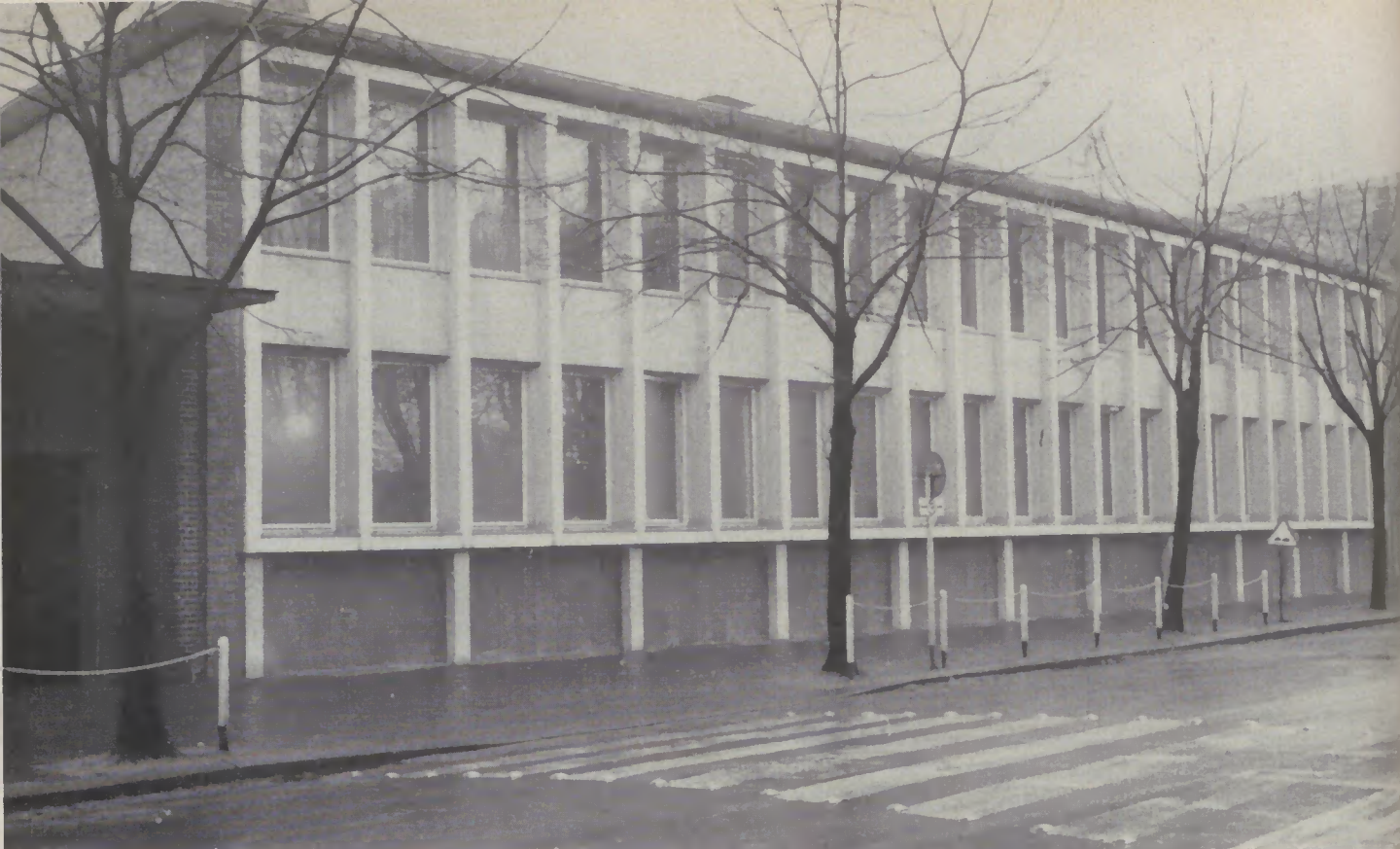
Im Laufe des Jahres wurde der Neubau Gesundheitshaus fertig und bezogen. Das sommerliche Laub der Bäume entzog die moderne Gliederung der Fassade in ihrer Gänze lange Zeit dem Auge der Kamera
