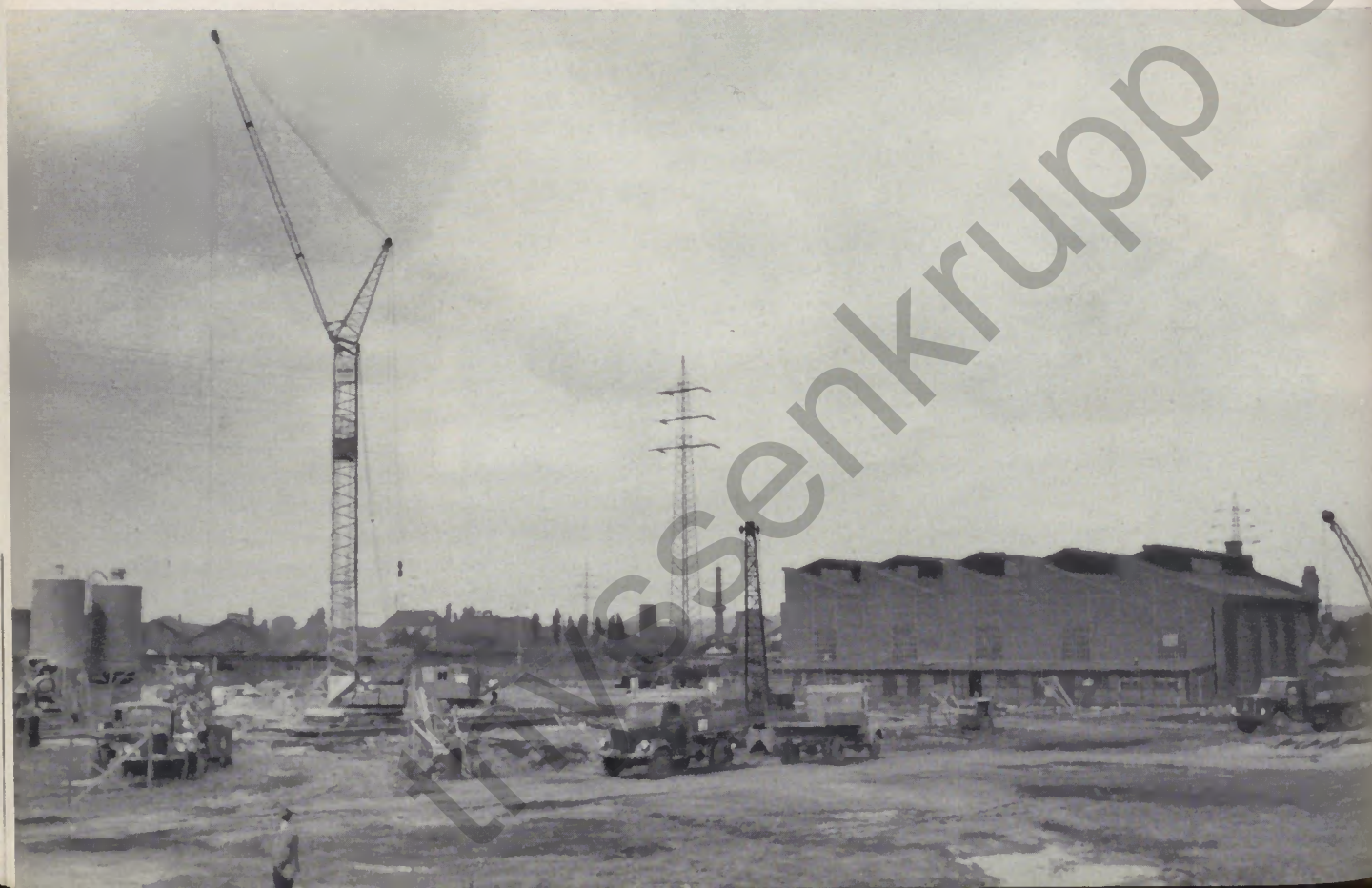
Ein Monat nach dem ersten Spatenstich zu unserem neuen Elektro Stahlwerk bot die Baustelle das gewohnte Bild mit Baggern, Kränen und Zement-Silos
