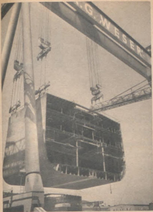
▲ Bis zu 500 Tonnen wiegen die vorgefertigten Volumenbauteile, manchmal ganze „Schiffsscheiben“, die der turmhohe Bockkran über den Helgen zur Montage fährt
