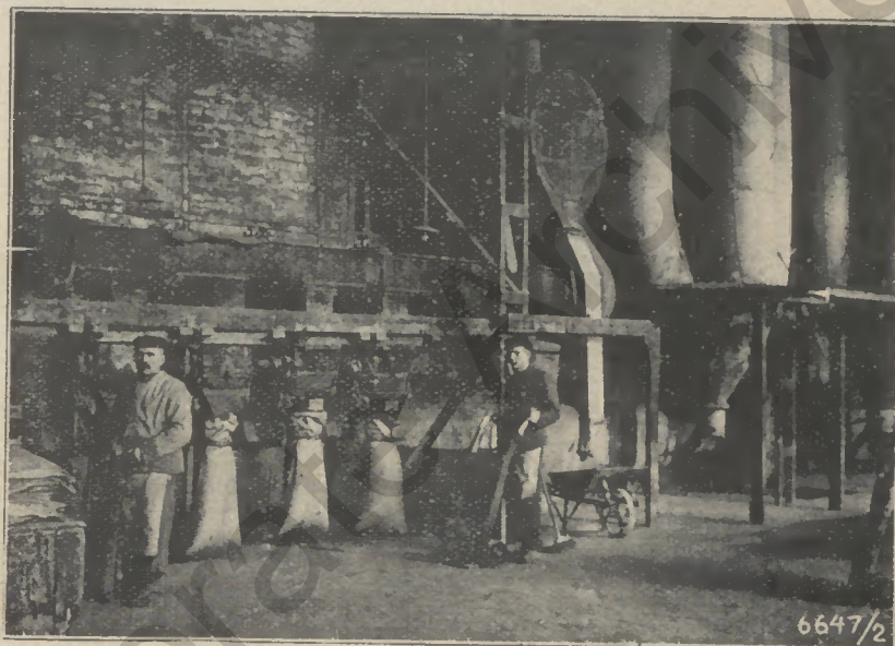
Das fertige Thomasmehl wird durch eine Maschine gefaßt
