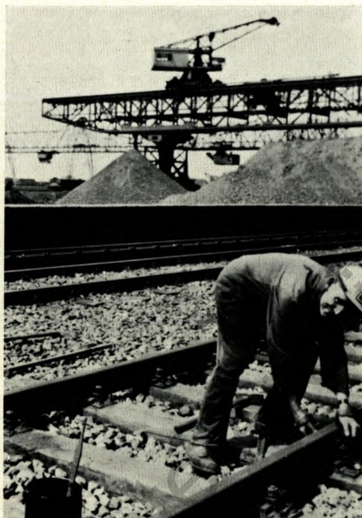
Gleiswerker Hollnack beim Teeren von Laschenschrauben.
