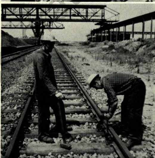
Das Lösen von Laschenschrauben mit dem Vorschlaghammer erfordert Muskelpflicht.
