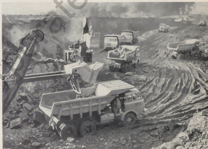
Beim Autobahnbau Haslinghausen – Wuppertal sind 15 Henschel HS 3-180 TAK im Einsatz
