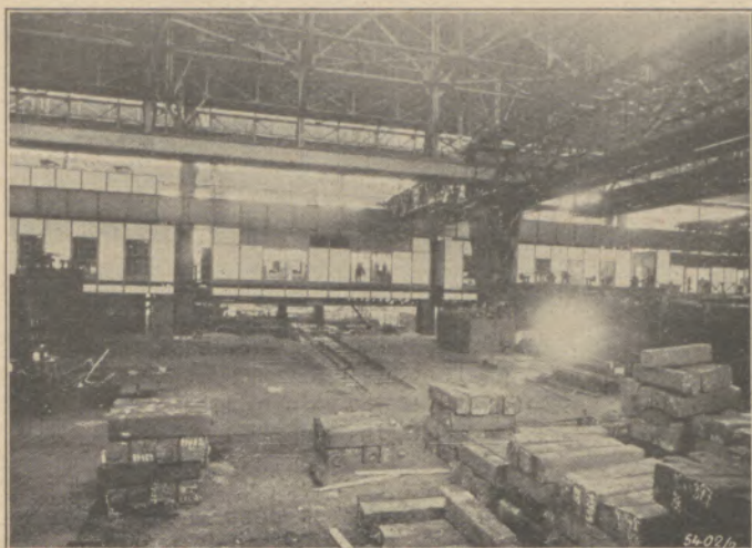
Wärmeofen im neuen Walzwerk der Dortm. Union
