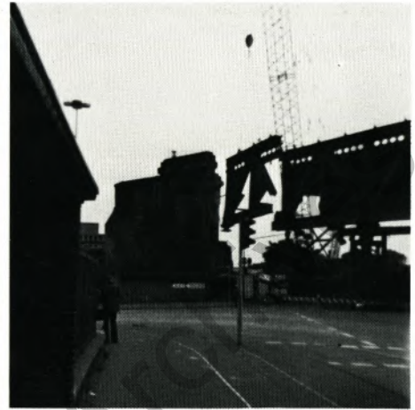
Ein Brückenteil wird demontiert
