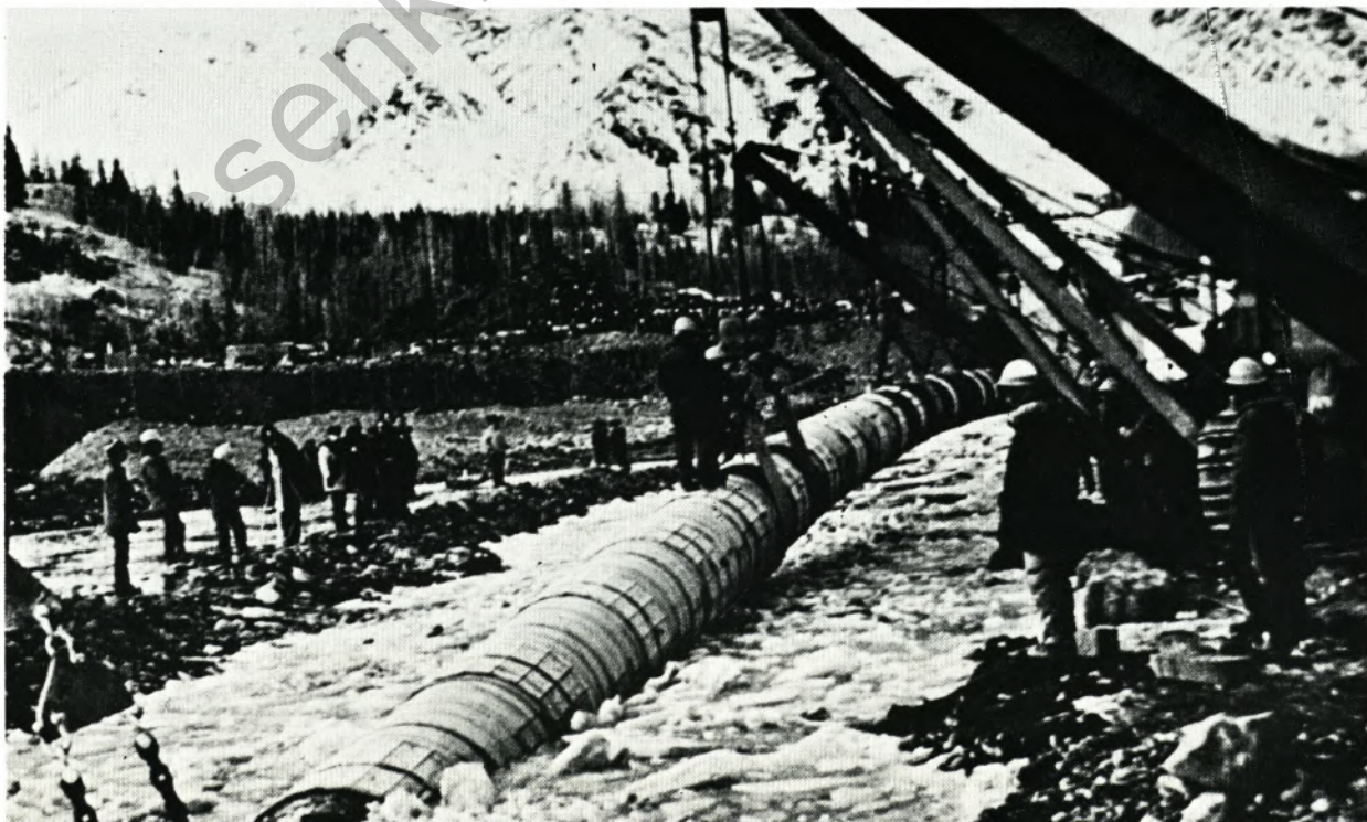
Verlegen des Rohrstranges in den Erdbereich
