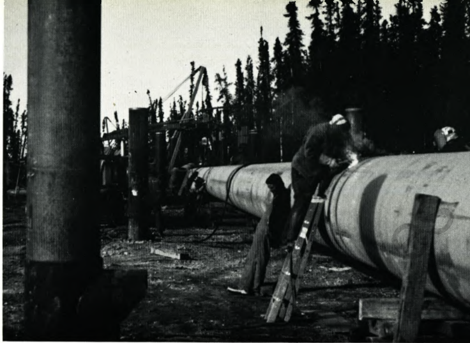
Schweißarbeiten an der Pipeline im Sommer
