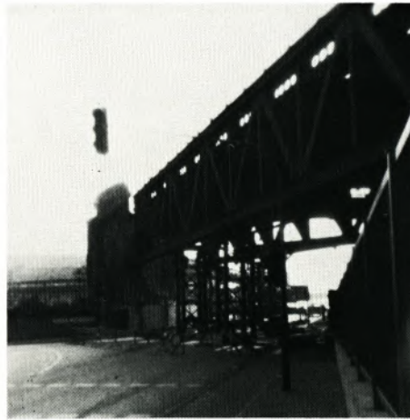
Nach erfolgter Straßensperrung sind die Hilfsstützen aufgestellt
