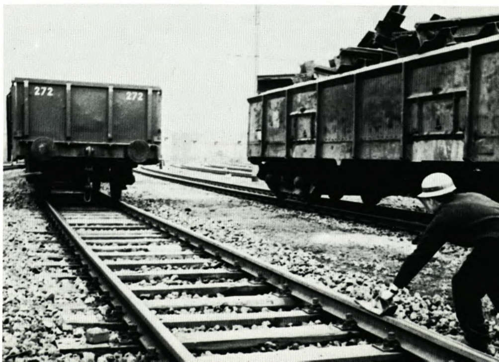
Durch rechtzeitiges Auslegen des Hemmschuhs läßt sich ein zu harter Aufprall der Wagen und damit eine erhebliche Lärmquelle verhindern
