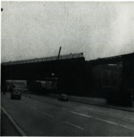
Das Bauwerk vor der Demontage
