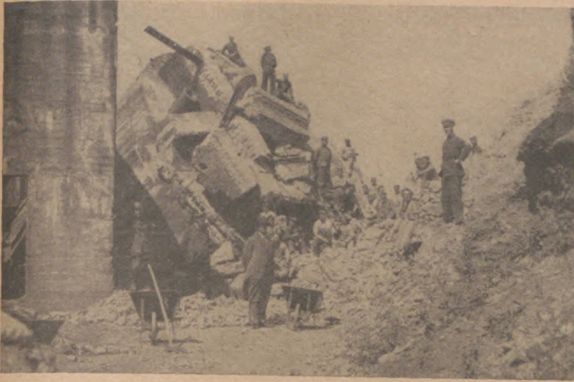
Maschinenfundamente werden durch Sprengung beseitigt
